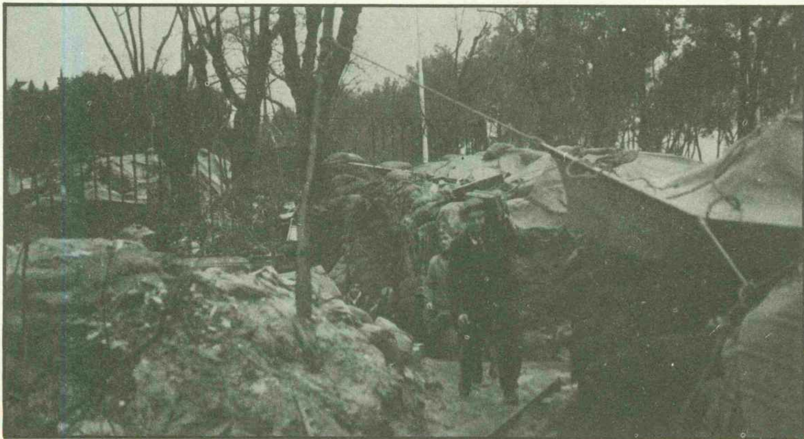
Construyendo trincheras en la plaza de la Moncloa, para detener a las fuerzas facciosas.
